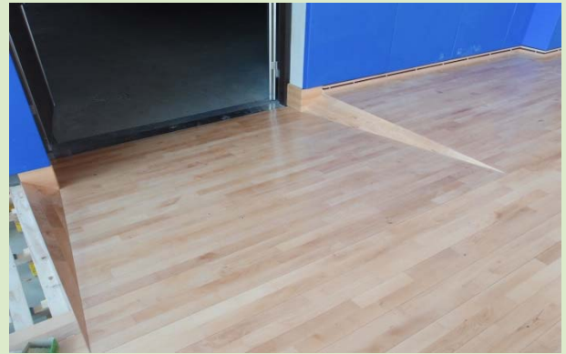
門口出入收邊完成照
