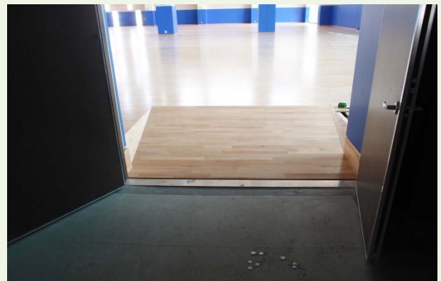
門口出入收邊完成照
