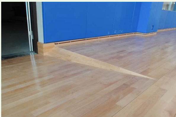
門口出入收邊完成照
