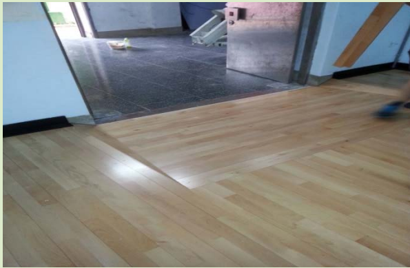
門口出入收邊完成照
